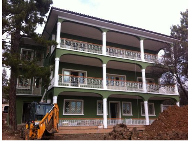
Şekil 20: Kalafatoğlu Konağı. 2019'daki Restorasyonu Kaynak: (Bölükbaşı Ertürk, 2019).
