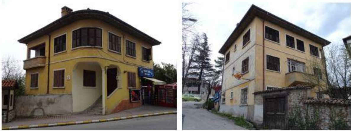
Şekil 21-22: Dumlu Konağı Kuzeydoğu ve Güneybatı Cepheleri
