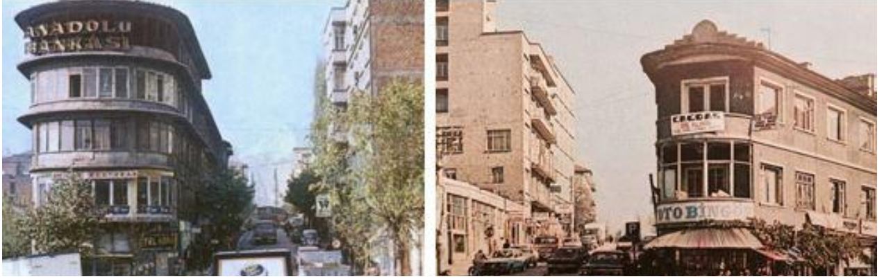
Şekil 3-4: Karabük Kent Merkezinde Meydanı Çevreleyen Anadolu Bankası Binası (solda) Karşısında Benzer Cephe Özellikleri Gösteren Diğer Bina (sağda)
