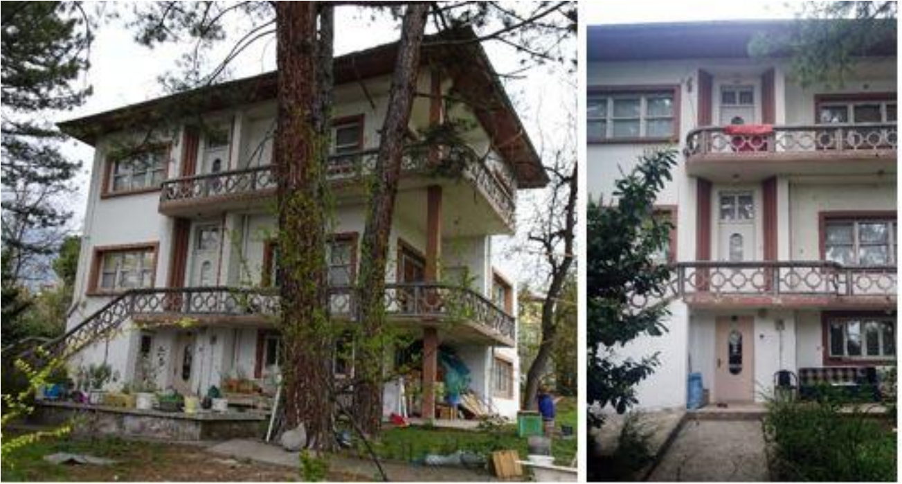
Şekil 11-12: Ganioglu Konağı Güney Cephesi ve Giriş Kapıları
