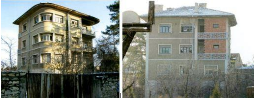
Şekil 39-40: Gökay Apartmanı Kuzeybatı ve Doğu Cephe Görünüşleri
