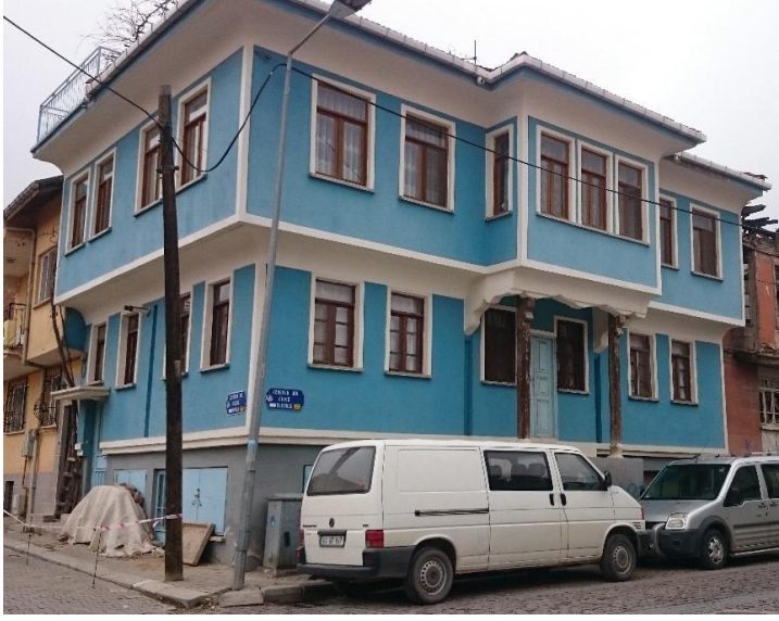
Fotoğraf 11. Özdemir Mahallesi Gediz Uluyolu ile Çıkrık Sokak Köşe
