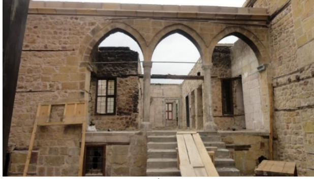
Göncü Konağı İç Avlu Cephesi
