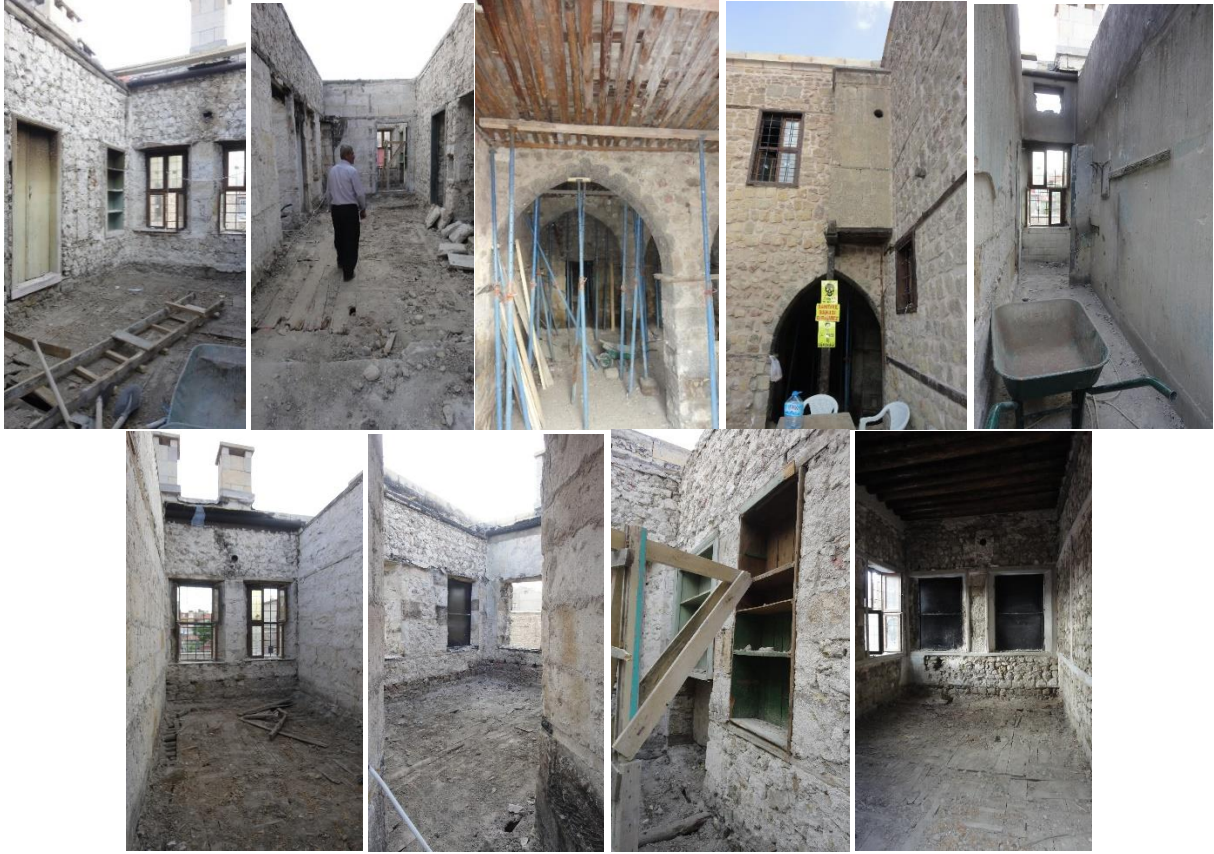
Şekil 15. Göncü Konağı Restorasyon Çalışmaları (Efe Yavaşcan, 2014).
