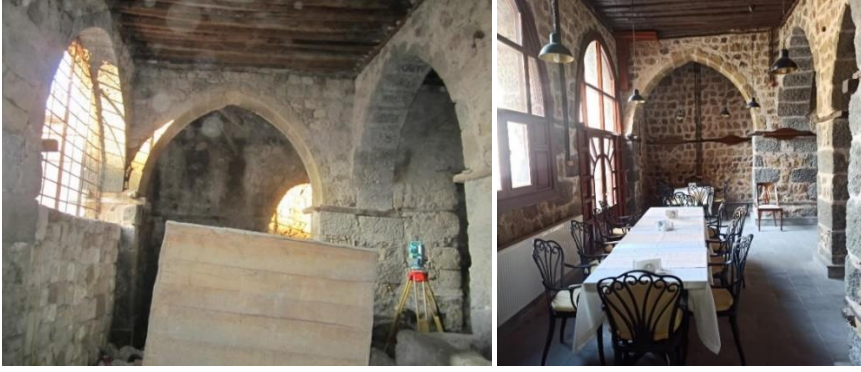
Solda restorasyon çalışmaları öncesi zemin kat (Niğde Müze Müdürlüğü, 2012), sağda restorasyon çalışmaları sonrası zemin kattaki servis mekanlarının yemek bölümüne dönüşümü (Efe Yavaşcan, 2023).
