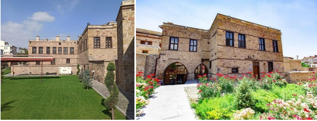
Restorasyon çalışmaları sonrası sağda güney cephe-bahçe (Efe Yavaşcan, 2023), sağda batı cephesi-bahçe (URL-1, 2016).
