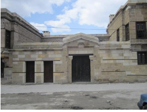
Göncü Konağı Sokak (Doğu)Cephesi
