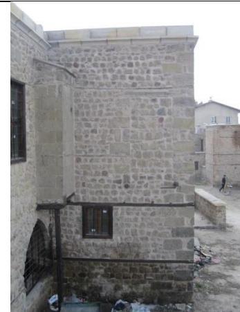
Göncü Konağı Kuzey Cephesi
