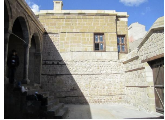
Göncü Konağı İç Avlu Cephesi
