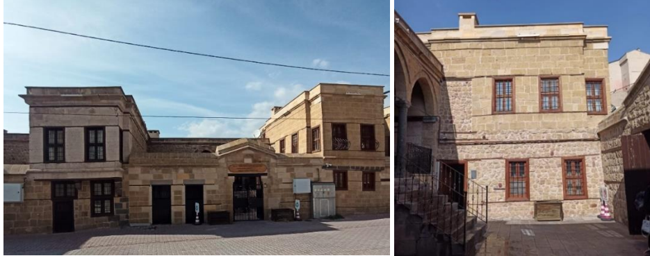
Restorasyon çalışmaları sonrası sokak cephesi ve iç avlu komşu yapıya ait cephe (Efe Yavaşcan, 2023).
