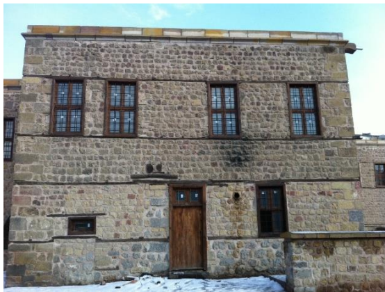
Göncü Konağı Batı Cephesi Devamı
