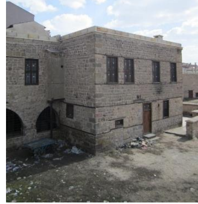
Göncü Konağı Batı Cephesi Devamı
