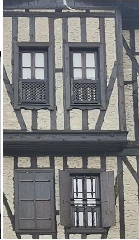
Resim 49. Alt ve Üst Kısma Tekli Olarak Yerleştirilmiş Köşe Penceresi-Sol
