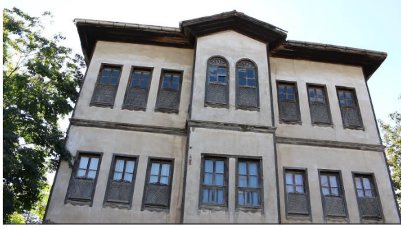
Resim 39. Alt Sıralara Yerleştirilmiş Çapraz Kafesler
