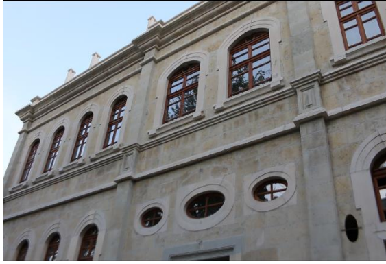
Resim 58. Eski Hastane Binası
