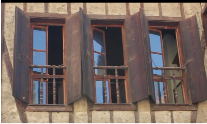
Resim 41. Alt Sırada Yerleştirilmiş Parmaklıklar
