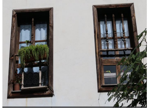
Resim 47. Alt Sıraya Üçerli Yerleştirilmiş Parmaklık -Sol Resim 48. Üst Sıraya Üçerli Yerleştirilmiş Parmaklık -Sağ
