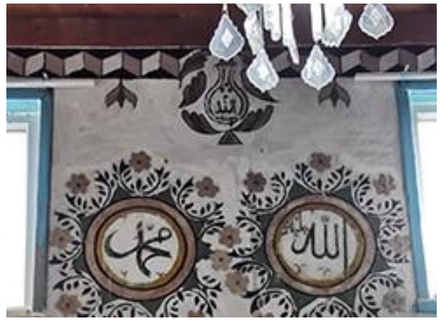
Resim 15. Güney Duvarı Üst Kısım Detay
