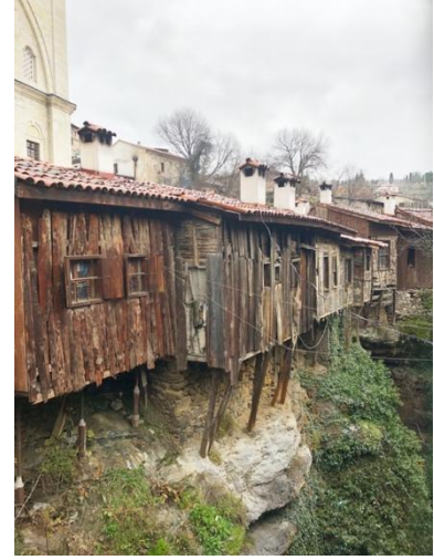
Resim 15. Akçasu Kanyonu üzerindeki Çatma Dükkanlar, Bakırcılar Çarşısı, Safranbolu. 18. yy sonu. Bu yapı tarzına Safranbolu'da Arapça drb kökünden "daraba" denmektedir. ©İbrahim Canbulat
