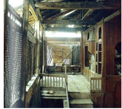
Resim 20. Safranbolu, Bağlar'da Kabakçılar Çardak Evi. 18. yy (Günay, 1998, s. 178 r. 104, 106)
