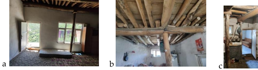
Resim 15. Ahşap Dikme ve Kiriş Birleşimi (a. Öneri No: 19, b. Öneri No: 12, c. Öneri No: 10)
