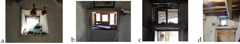
Resim 23. Özgün küçük boyutlu (a-b) ve kapı üstü pencereler (c-d)
