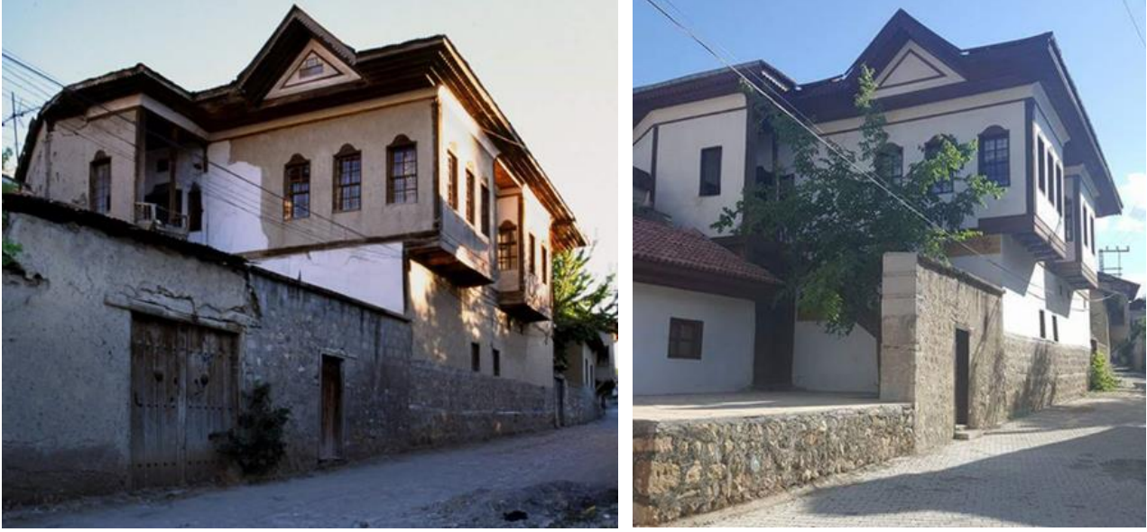
Resim 54-55. Şeyhođlu Konađı Restorasyon Öncesi ve Sonrası Giriş Kapısı (yazar arşivi)
