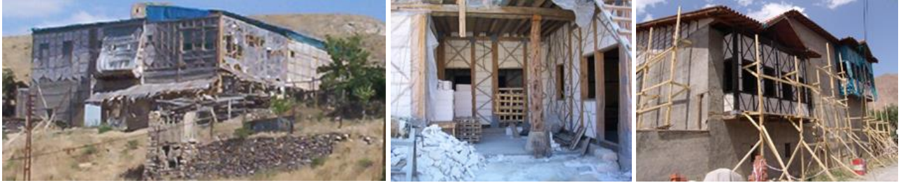
Resim 69-70-71. Abdullah Paşa Konağı, Rekonstrüksiyon Uygulaması 2005 (yazar arşivi)
