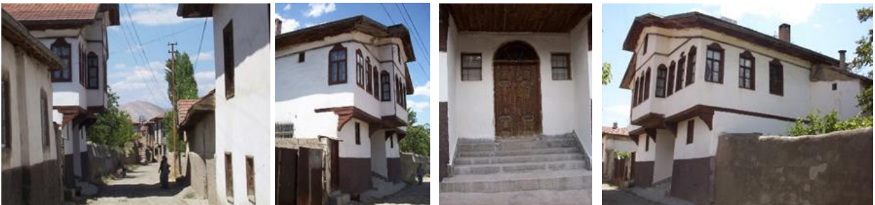
Resim 79-80-81-82. Gülten Demiralay Evi Cephesi ve Giriş Kapısı (yazar arşivi)
