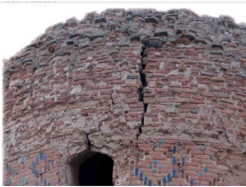
Resim 1. Batman Zeynel Bey Türbesi, Taşıyıcı Duvarlarda Yarılma-Ayrılma (Solda) (Eskici vd., 2008: 25).
